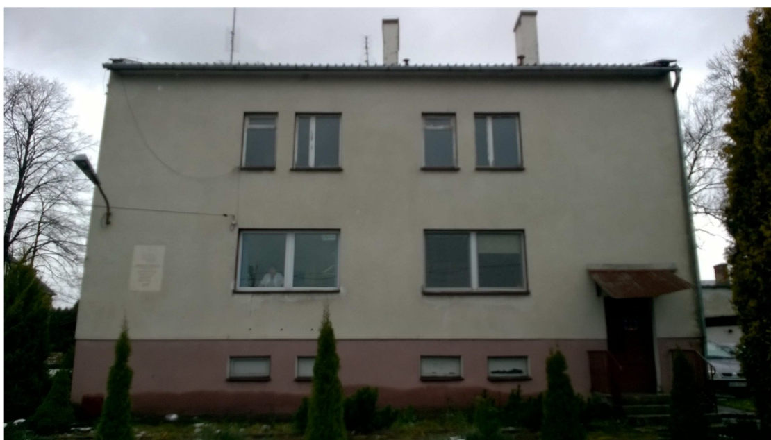
Zdj.2 Budynek „A” elewacja północno-wschodnia
