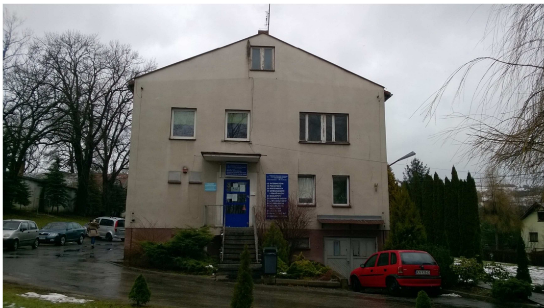
Zdj.1 Budynek „A” elewacja południowo-wschodnia
