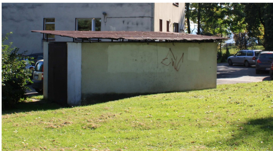
Zdj.4 Budynek „B” elewacja zachodnia
