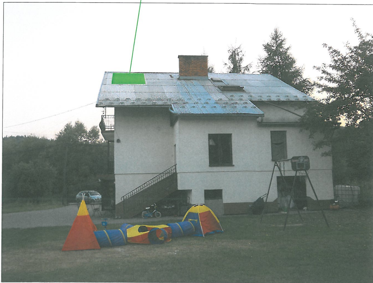
PROJEKTOWANE TRZY PANELE SŁONECZNE
